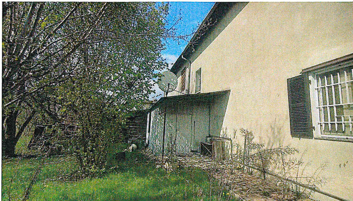
VISTA PROSPETTO OVEST
